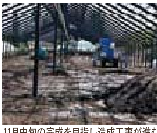
11月中旬の完成を目指し造成工事が進む
