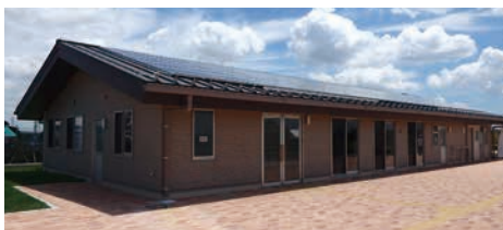
クーラーも設置され快適な大型クラブハウス。コイン式シャワー室も完備されている
